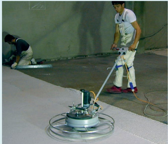
Die extralange Führungsstange ist stufenlos auf jeden Bediener einstellbar. Der Durchmesser des Werkzeugtellers von 820 mm ergibt einen großen Aktionsradius
