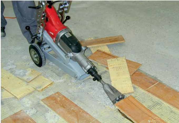
Abschälen von schubelastisch verklebtem Parkett und Laminat
