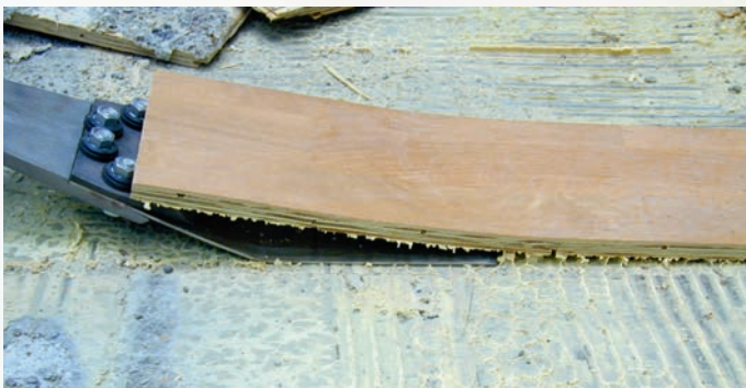
Entfernen von Presskies
